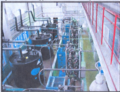
Рисунок 4. Зал электролизной на ОСВ-1 г. Ростова-на-Дону
