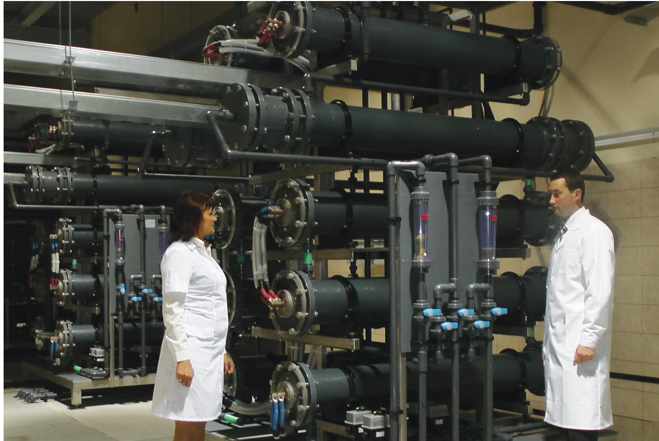
Рисунок 5 Электролизная станция с семью установками «Хлорэфс» производительностью 7 т/сут. по эквиваленту хлора для обеззараживания питьевой воды г. Ростова-на-Дону.
