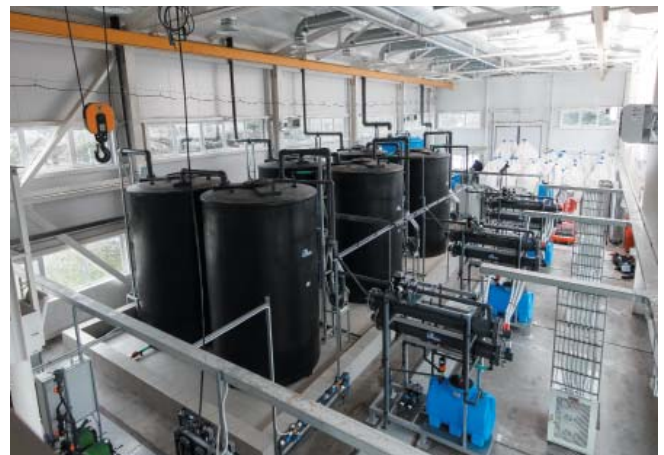
Рис. 3. Три электролизных установки «Хлорэфс» производительностью по 250 кг/сут каждая на Партизанских ВОС производительностью 100 тыс. м 3 /сут питьевой воды для нужд г. Симферополя (2019 г.)
