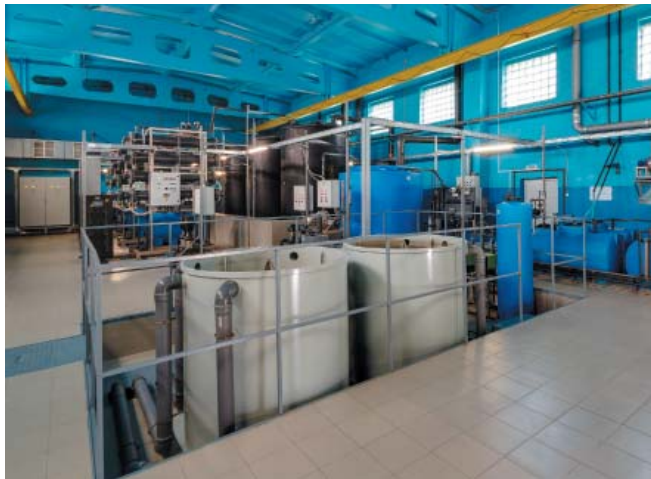
Рис. 4. Три электролизных установки «Хлорэфс» производительностью по 500 кг/сут каждая на канализационных очистных сооружениях КОС-2 г. Краснодара (2017 г.)
