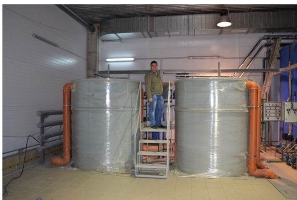
Рисунок 7. Электролизная станция «ХЛОРЕФС» производительностью 2000 кг/сут э.а.х. на Краснооктябрьских ВОС г. Волгограда
