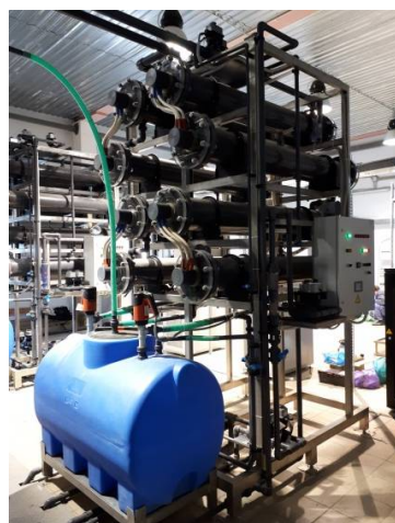
Рисунок 6. Три электролизных установки «ХЛОРЕФС» по 500 кг/сут каждая на Левенцовских ВОС производительностью \text{м}^3/\text{сут} питьевой воды для нужд
