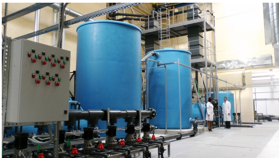
Рисунок 2. Узел кислотной декарбонизации рабочего солевого раствора на Александровских ОСВ г. Ростова-на-Дону
