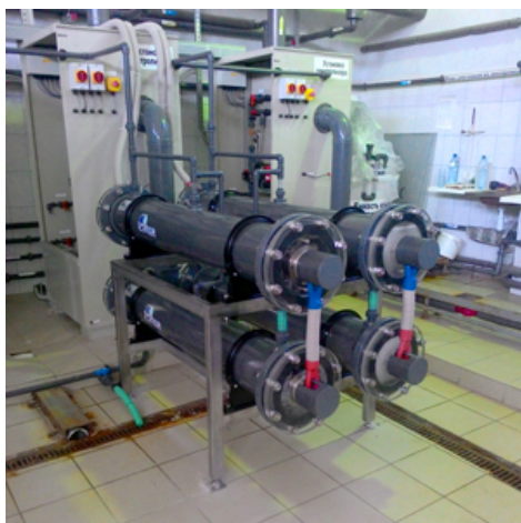
Рисунок 4. Четыре электролизера «Хлорэфс» взамен вышедшим из строя «GRUNDFOS/ALLDOS» производительностью 150 кг хлора в сутки каждый
