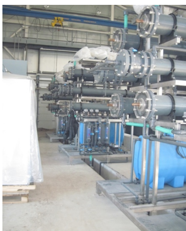
Рисунок 6. Три электролизных установки «ХЛОРЕФС» по 500 кг/сут каждая на Левенцовских ВОС производительностью \text{м}^3/\text{сут} питьевой воды для нужд
