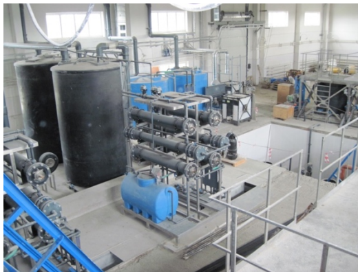
Рисунок 5. Две электролизных установки «ХЛОРЕФС» по 500 кг/сут каждая на водозаборе из р. Дон
