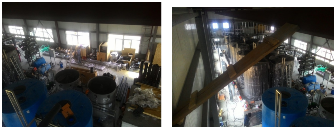
Рисунок 8. Монтаж электролизной станции «ХЛОРЕФС» производительностью 1500 кг/сут э.а.х. на водозаборе г. Якутска
