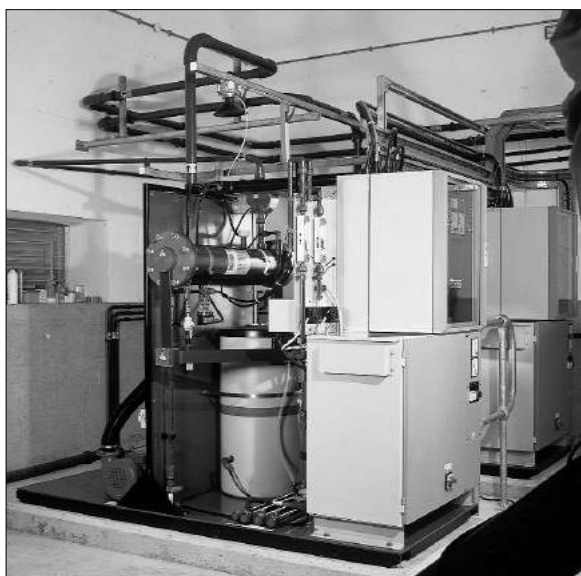
Рисунок 2. Мини-установка OSEC (8 – 34 кг экв. хлора в сутки)
